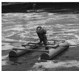
Figura 7.2 Bacia de equalização: a) medidor de caudal de afluente e b) equipamento flutuante de mistura e arejamento
