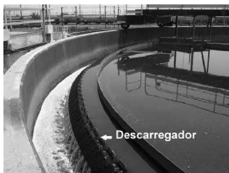
Figura 11.10 Sistema de recolha do efluente decantado
