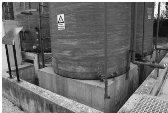
Figura 20.10 Bacia de retenção com vários contentores
