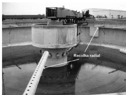
Figura 11.12 Sistema radial de recolha de decantado
