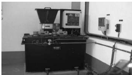
Figura 20.12 Câmara de mistura para preparação de reagentes
