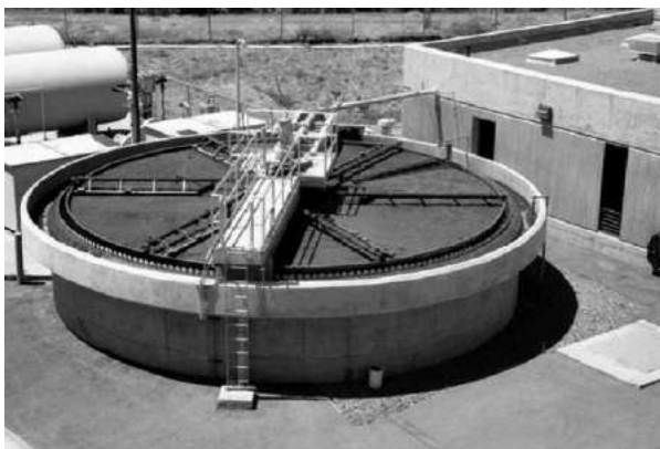
Figura 12.5 Flotador circular
