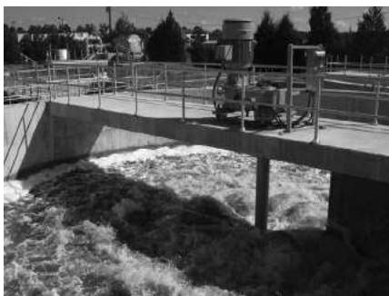
Figura 13.6 Turbina de arejamento de eixo vertical
