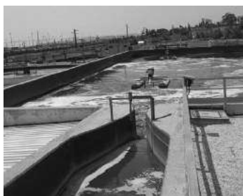
Figura 7.2 Bacia de equalização: a) medidor de caudal de afluente e b) equipamento flutuante de mistura e arejamento
