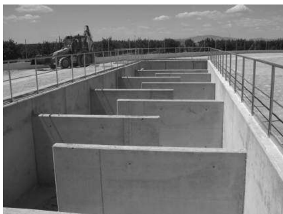
Figura 17.4 Floclador hidráulico de chicanas
