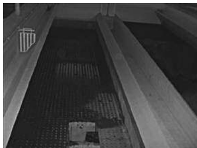
Figura 14.16 Reparação da laje de fundo de um filtro de meio granular
