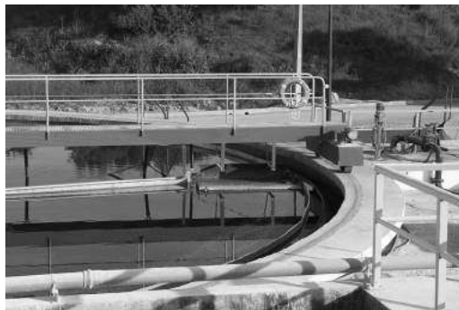
Figura 11.16 Soleira de deslocação da ponte raspadora
