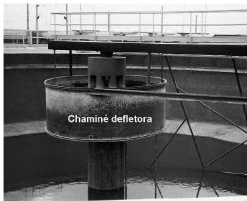
Figura 11.9 Defletor da entrada central do decantador
