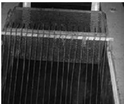
Figura 6.6 Cesto de recolha de gradados
