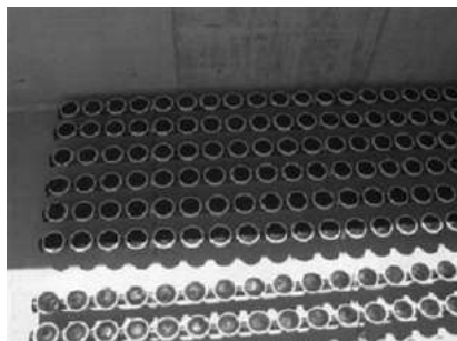
Figura 8.6 Difusores de ar comprimido
