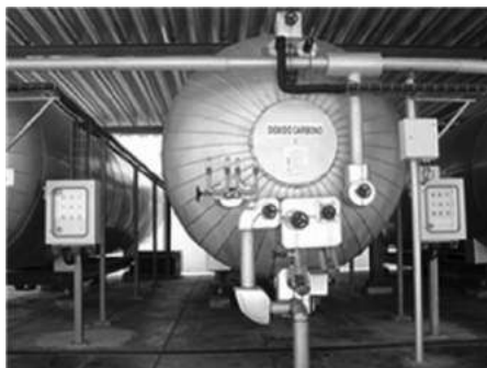
Figura 20.2 Armazenamento de CO 2 no exterior, sob telheiro
