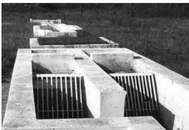
Figura 6.1 Grades de limpeza manual
